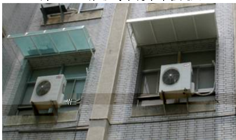
圖 2.3.13 正確的室外機安裝方式
