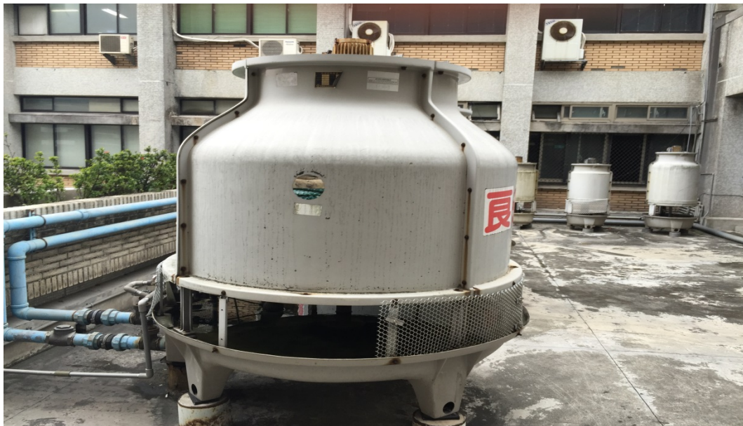
圖 2.1.15 冷卻水塔
